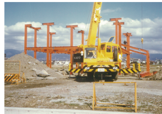
建設中の様子です。今と違い、周りは畑が多いです。
